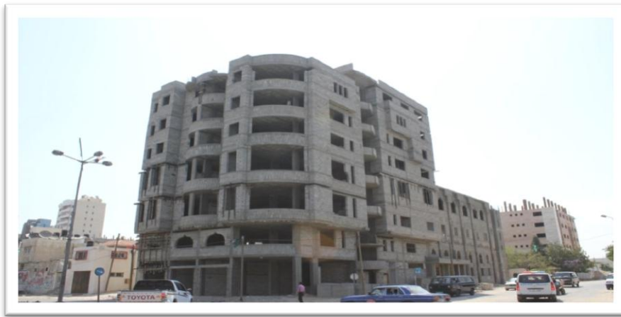
شكل (5.4): مشروع إنشاء مبنى البلدية الاستثماري المصدر : بلدية غزة
